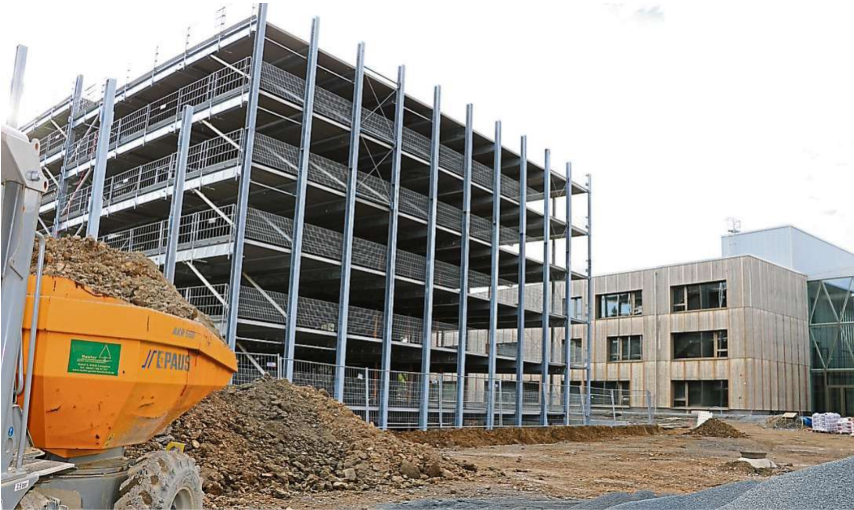
Blick auf die Baustelle im Wetzlarer Spilburg-Gelände: Hinten steht der Neubau der Theodor-Heuss-Berufsschule, vorne wächst das Parkhaus eines Investors.Foto: Jörgen Linker
